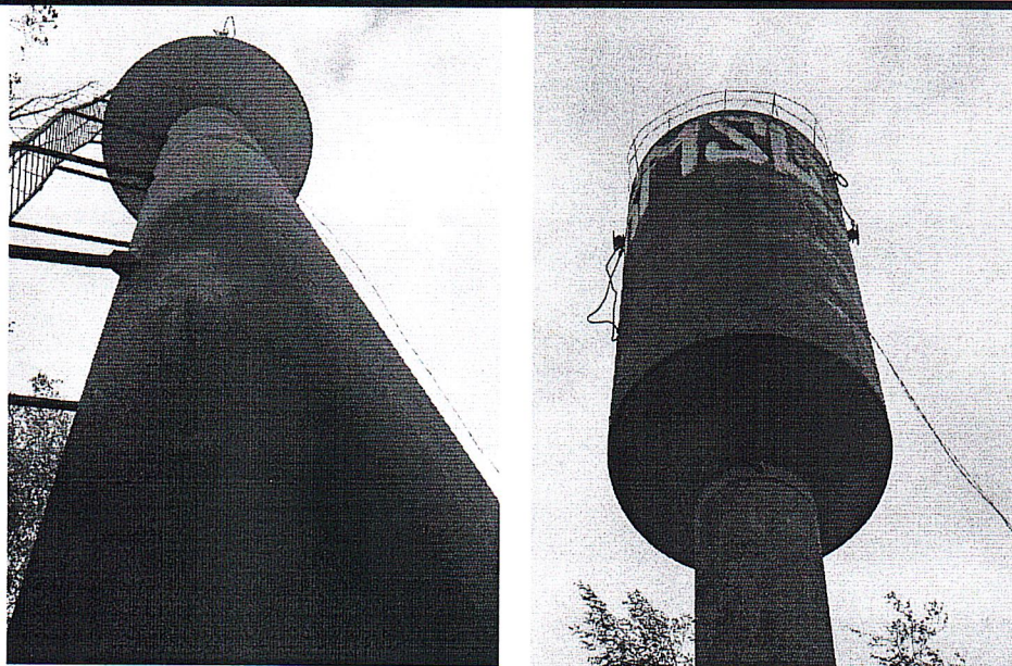
Фото 1-2. Обследуемая водонапорная башня.
